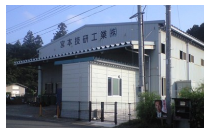
▲溶接加工工場外観
