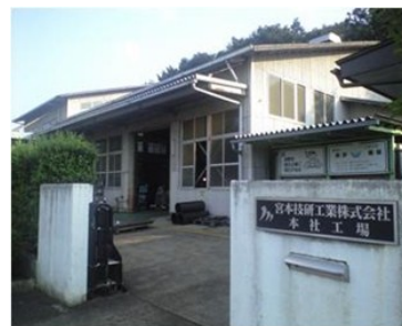
▲機械加工工場外観
