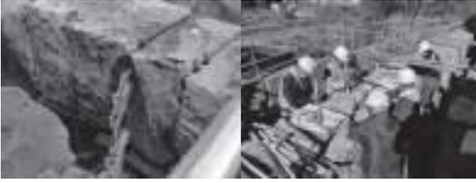
通水管からの漏水状況      受益者(通潤地区土地改良区)による漆喰の詰替え
