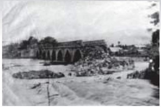
図9 二代目信夫橋落橋『信夫橋 1』より
